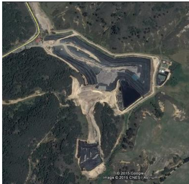
Fotografía 7. Vista de planta Relleno Sanitario Nuevo Mondoñedo
